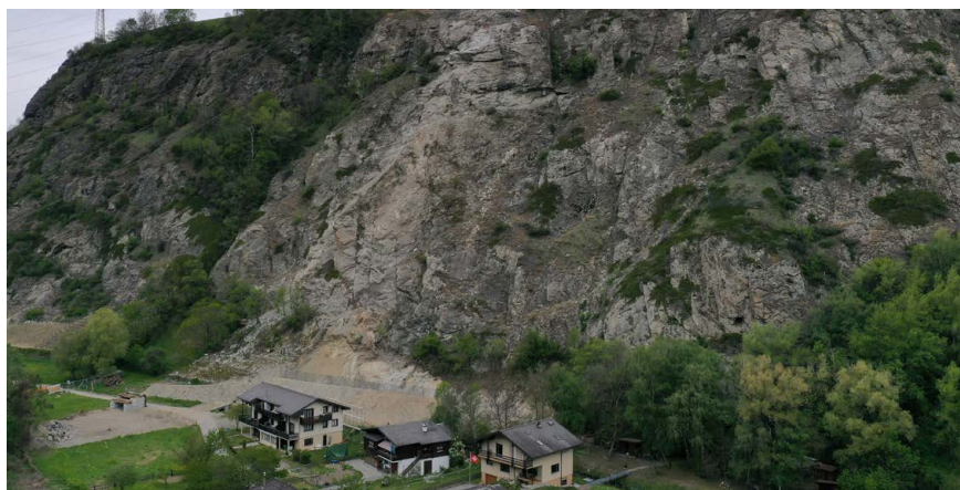
Drohnenaufnahme der Situation in Brigerbad nach dem Erdbeben.
